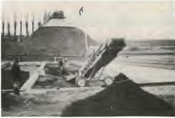
Bild 10: Räumen eines Trockenbeetes mit elektrischer Schaufel und Förderband.
