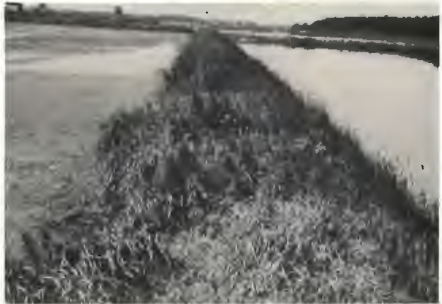
Bild 12: Große Erdbeeten als Trockenbeete. Links: Teilweise getrocknet. Rechts: Frisch beschickt.
