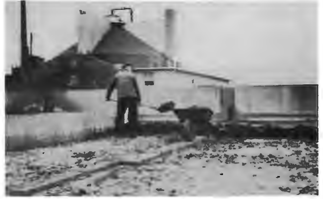
Bild 9: Stichefester Schlamm wird in mühsamer Handarbeit aus einem Trockenbeet geräumt.
