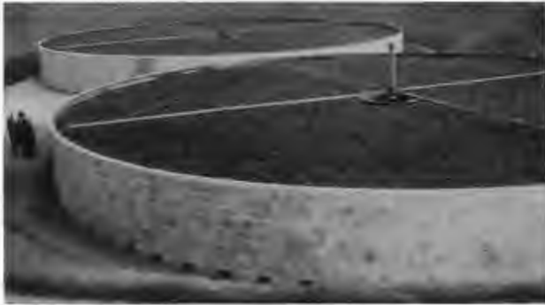
Bild 1: Tropfkörper mit sich drehendem Berieselungskreuz.
