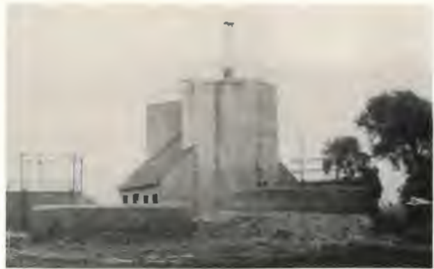
Bild 4: Bihugasanlage für Stallmist und Abwasserschlämme (ca. 40 GVE + 1000 Haushalte).
