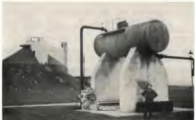
Bild 5: Ein Hochfaß als Zapfstelle für pumpfähigen Schlämme.
