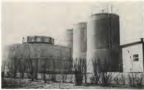
Bild 3: Abwasserabsetzbecken verbunden mit drei Schwemmstilsilos.
