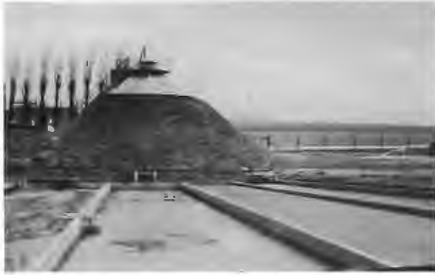
Bild 8: Schlamm-trockenbeete vor einem Faulturm.
