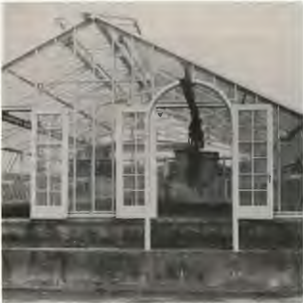
Bild 11: Ein kostspieliges Glashaus über einem Trockenbeet in regenreicher Gegend mit einer Hängebahn für den Transport des stichfesten Schlammes.
